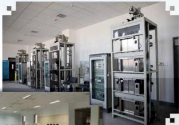
智能电梯安装调试维护训练场所
